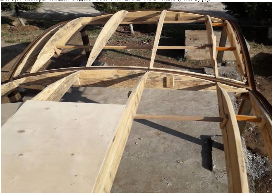
Рисунок 2 – Изготовление деревянной опалубки для армирования
