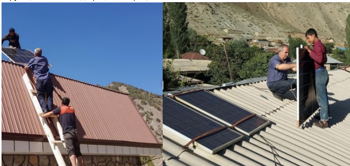
Рисунок 3 – Процесс установки солнечных панелей сотрудниками компании «Технологияҳои сабз» [8]
