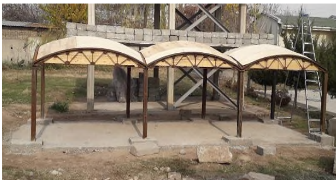
Рисунок 3 – Деревянная опалубка готова к армированию
