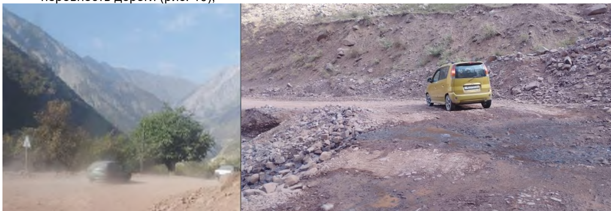
Рисунок 10 – Запыленность дороги и неровность дорожного полотна
