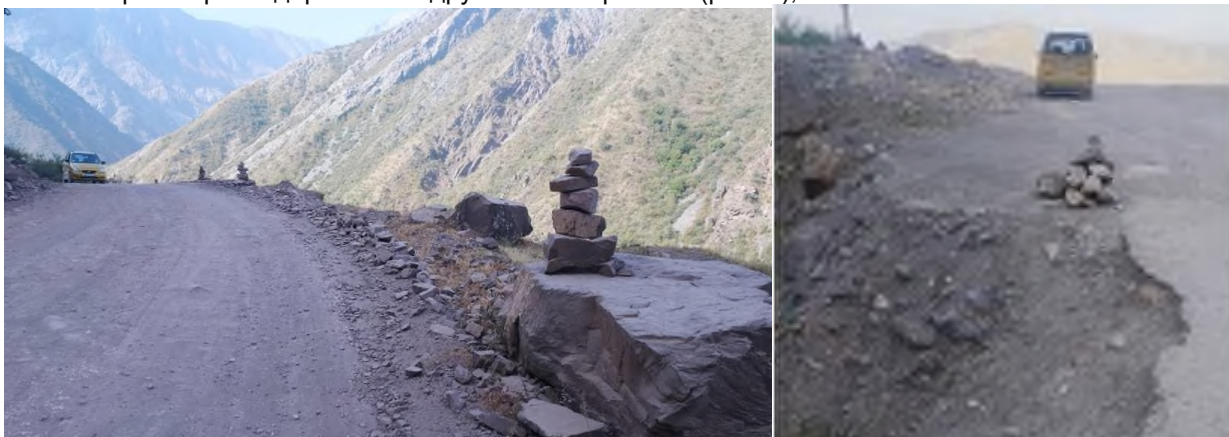
Рисунок 9 – Сужение участка дороги из-за нарушения дорожного полотна с указателем края обрыва дороги из подручных материалов
