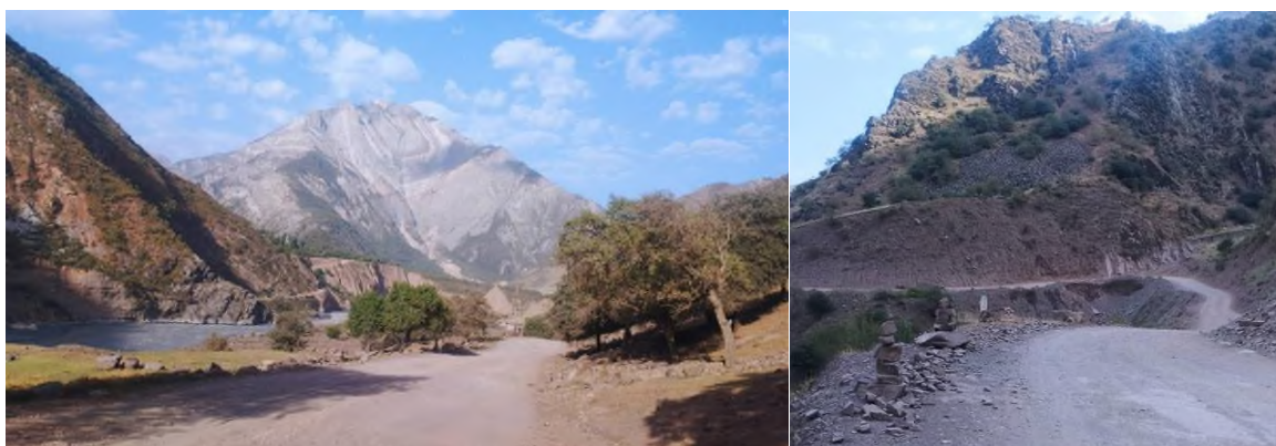
Рисунок 2 – Фрагменты автомобильной дороги на участке Обигарм–Сангвор (фото автора)
