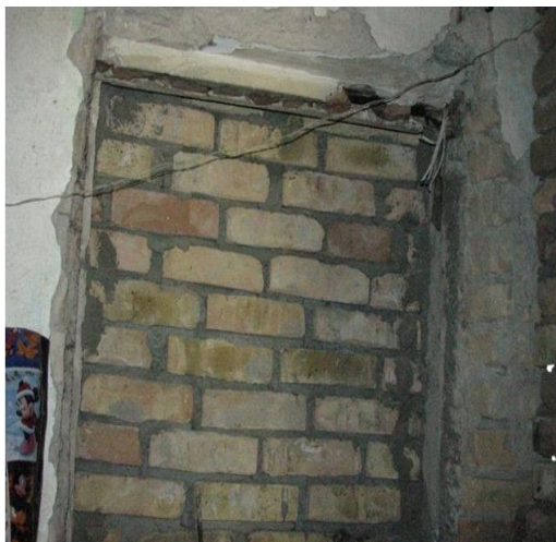
Рис.1. Заложение дверного проема кирпичной кладкой
