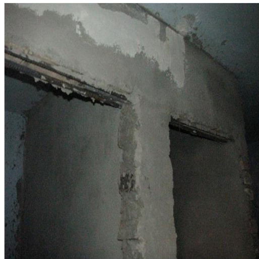
Рис.2. Армокирпичные перемычки в возведенных перегородках
